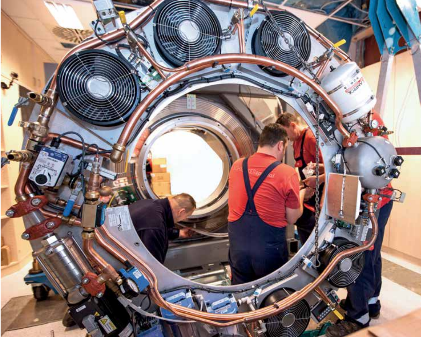
Eine eindrucksvolle Baustelle: das neue Bestrahlungsgerät während der Montage. Inzwischen ist es in Betrieb gegangen
