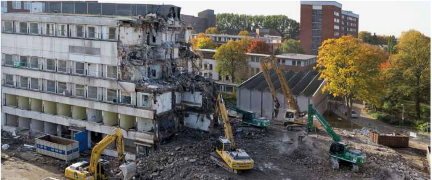
Beeindruckender Blick vom Neuen Klinikum hinüber zur ehemaligen Frauenklinik: Gleich fünf Abriss- und Räumbagger machen sich an dem alten Gemäuer zu schaffen. Die Arbeiten schreiten mit großer Geschwindigkeit voran
