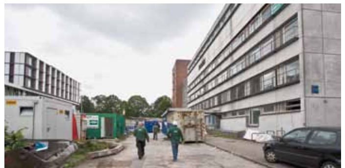
Großbaustelle UKE: Bis zum ersten Quartal 2014 gehören Baucontainer und Facharbeiter wieder zum Campus-Alltag
